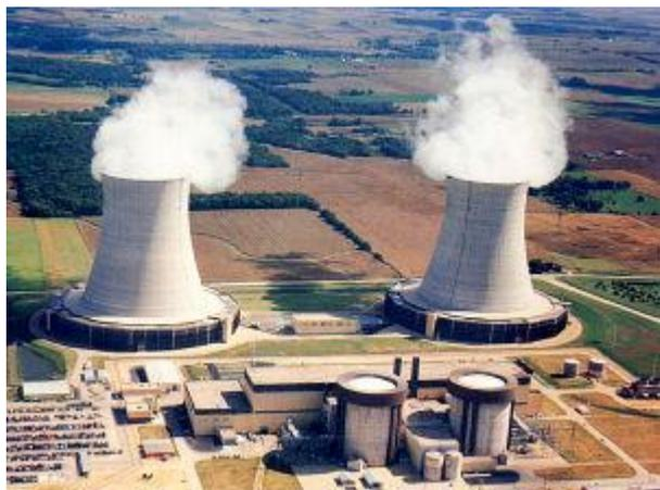
محطات التوليد النووية نوعا من محطات التوليد الحرارية لأنها تعمل بنفس المبدأ وهو توليد البخار بالحرارة وبالتالي يعمل البخار على تدوير التوربينات التي بدورها تدور الجزء الدوار من المولد الكهربائي وتتولد الطاقة الكهربائية على أطراف الجزء الثابت من هذا المولد .
