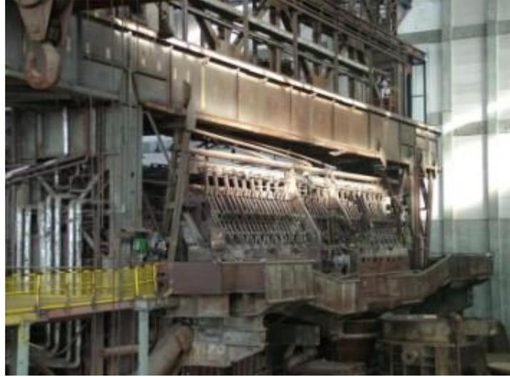
وهو عبارة عن وعاء كبير لحرق الوقود . ويختلف شكل ونوع هذا الوعاء وفقا لنوع الوقود المستعمل ويلحق به وسائل تخزين ونقل وتداول الوقود ورمي المخلفات الصلبة
