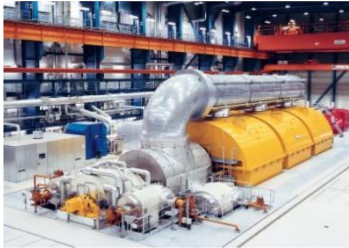
هو عبارة عن مولد كهربائي مؤلف من عض دوار مربوط مباشرة مع محور التوربين وعضو ثابت . ويلف العضوين بالأسلاك النحاسية المعزولة لتنقل الحقل المغناطيسي الدوار وتحوله إلى تيار كهربائي على أطراف العضو الثابت . ويختلف شكل هذا المولد باختلاف حجم المحطة .
